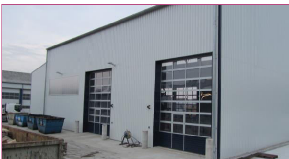
Konditionierungshalle Conditioning hall
