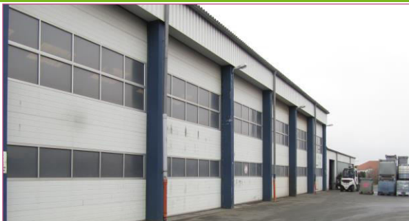
Toreinfahrten der Konditionierungshalle Gate entrances of the conditioning hall
