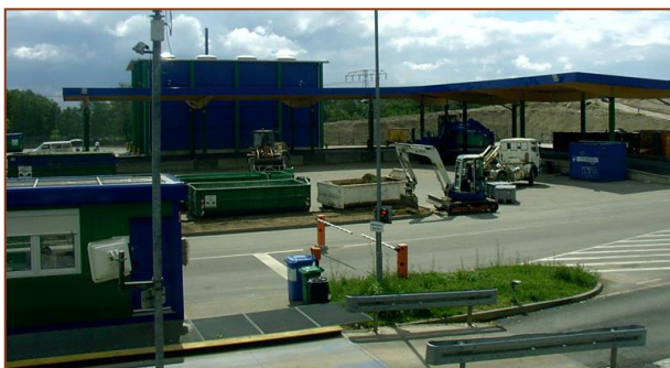
Eingangsbereich und Annahmekontrolle Entrance area of the depot and acceptance control
