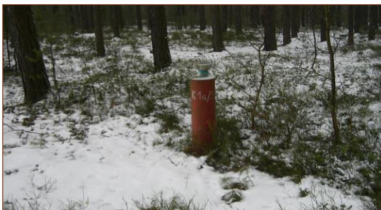
**Rohr zur Überprüfung und Nachfüllung der Wasservorlage**
