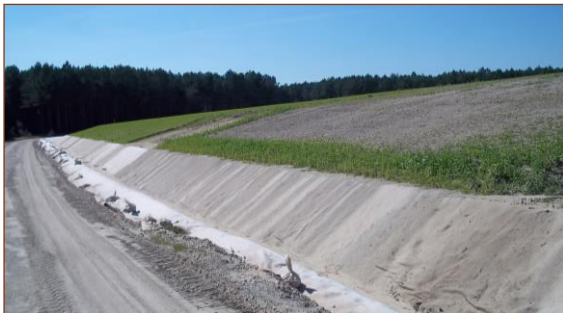
Auslegen des Entwässerungsgrabens mit einem Schutzvlies Laying drainage trench with a protective fleece
