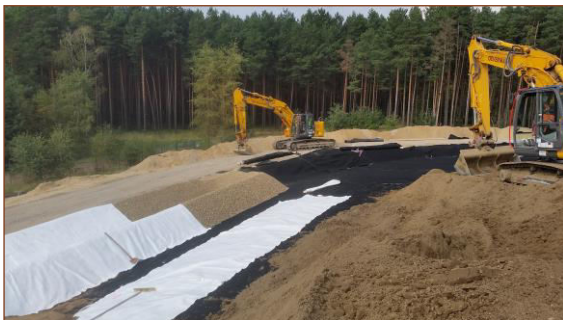
Verlegung der Kunststoffdichtungsbahn mit Schutzvlies Laying the plastic geomembrane with protevtive fleece
