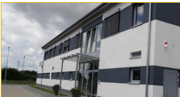
Bürogebäude Office building
