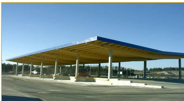
Überdachter Containerstellplatz Roofed container storage area
