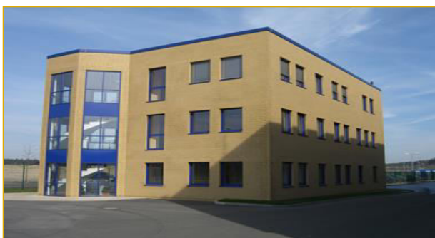
Betriebsgebäude Company building
