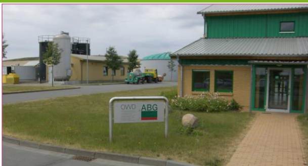
Eingangsbereich Betriebsgebäude Entrance area of the company building
