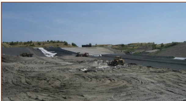
Basisabdichtung Base sealing
