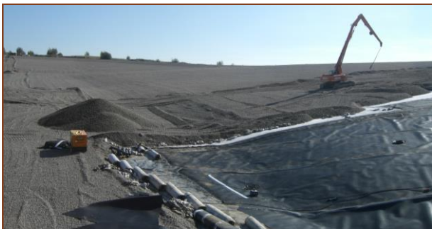
Oberflächenabdichtung Surface Sealing
