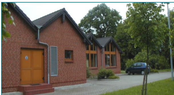
Wasserwerk Gnoien Waterworks Gnoien
