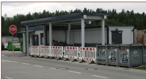
Annahmekontrolle und Schadstoffannahme Acceptance inspection and acceptance of hazardous waste
