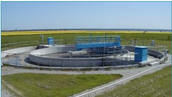
Kombinationsbecken mit Belebung und Nachklärung Secondary clarifier and activation tank in Breege
