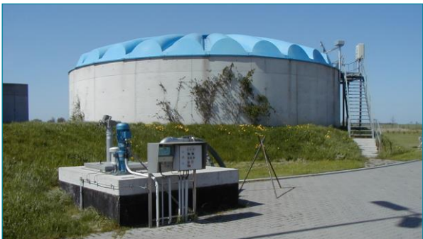
Schlammstapelbehälter Sludge stacking tank
